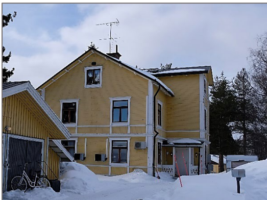
Bild nr. 1 Äldre fastighet, Ängsgatan. © Norrbottens museum
