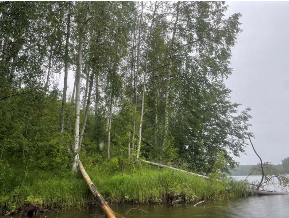
Figur 5. Slänter mot vattnet vid ca 0/100.
