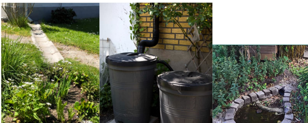
Figur 11. Exempel på rännnal från utkastare till plantering, seriekopplade regntunnor samt en liten dagvattendamm.
