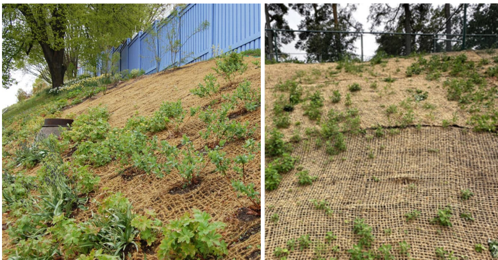
Figur 10. Exempel på nyetablerad kokosmatta i slänt.
